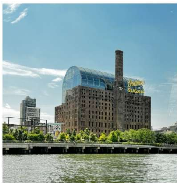
The Refinery at Domino. 1856年建築の米国最大の砂糖工場を外壁だけ保存し、内部にオフィスや住宅等の複合空間を建設。
